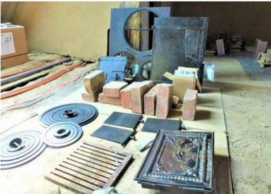
*Dachgeschoss: Restaurierte Herdteile für den Wiederaufbau der Kochmaschine im Dachgeschoss. Foto: Cornelia Lehmann.*
